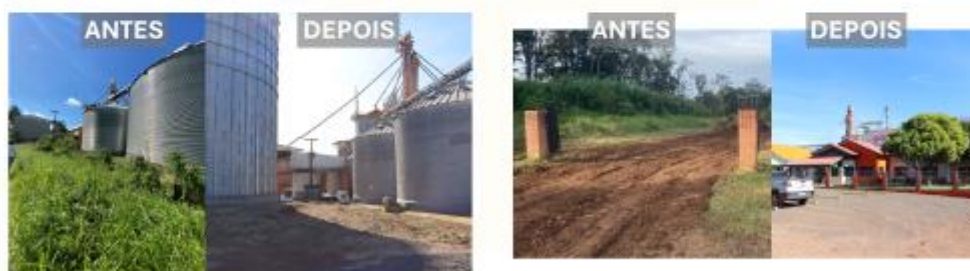
Figura 7: Silos e entrada principal — Substituição e modernização de estruturas, melhorando armazenagem e acesso.
