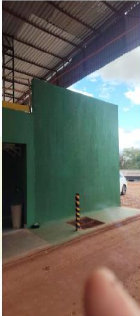
Figura 1: * Ampliação da estrutura do escritório principal
