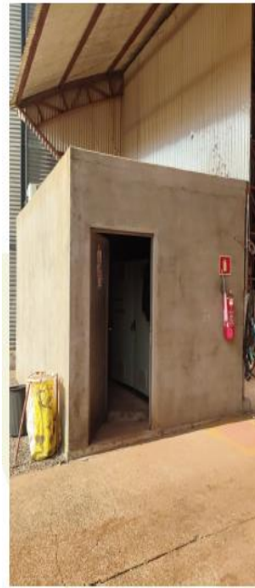
Figura 5: * Sala de comando reformada com nova automação
