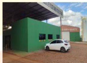
Figura 2: * Vista externa da nova ala administrativa
