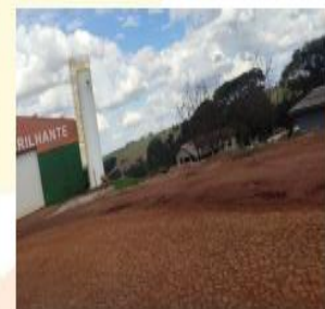
Figura 8: * Caixa d'água de 35 mil litros instalada para abastecimento interno
