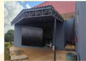
Figura 6: * Oficina mecânica nova com almojarifado integrado
