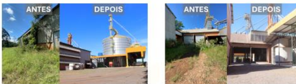
Figura 6: Moega e fornalha — Atualização de equipamentos e reorganização de layout para eficiência térmica e operacional.
