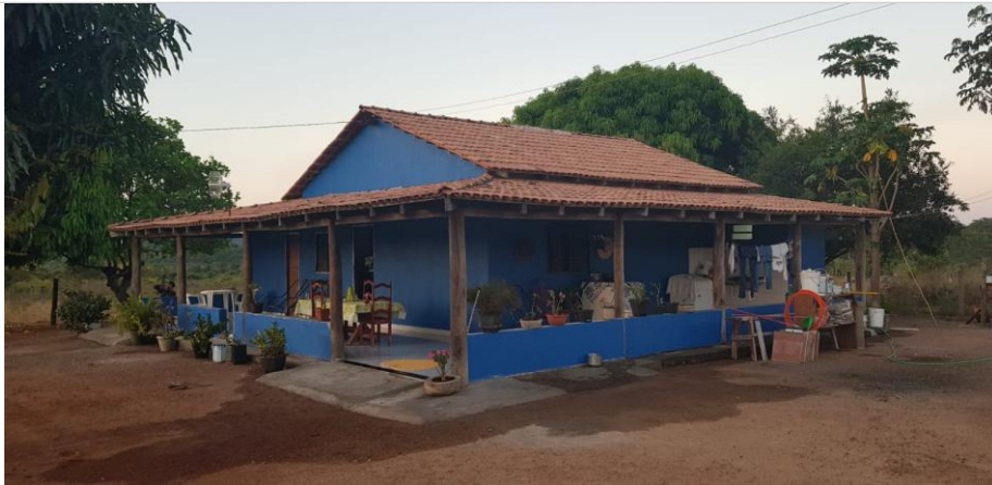
CASA SEDE (DEPOIS) – FAZENDA 2F / SANTA TEREZINHA MT
