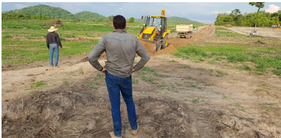
OBRA ESTRADA FAZENDA 2F / SANTA TEREZINHA MT
