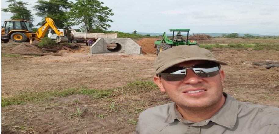
OBRA ESTRADA / FAZENDA 2F / SANTA TEREZINHA MT
