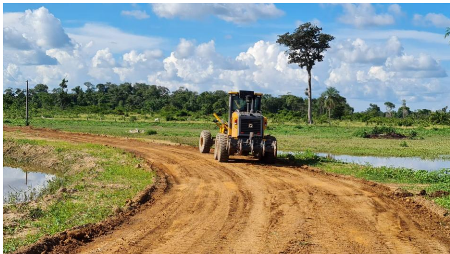
OBRA ESTRADA FAZENDA 2F / SANTA TEREZINHA MT
