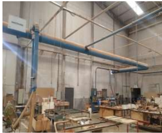
• Sistema de Exaustão, linhas elétricas/ar comprimido e marcenaria
