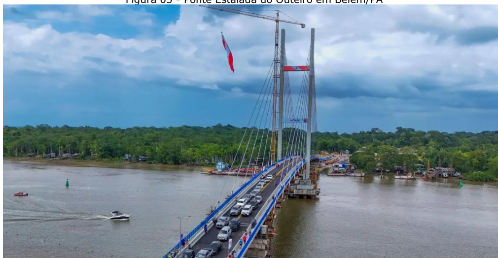
Figura 05 - Ponte Estaiada do Outeiro em Belém/PA
